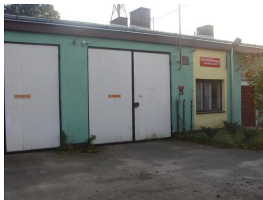
Budynek OSP w Woli Pękoszewskiej
